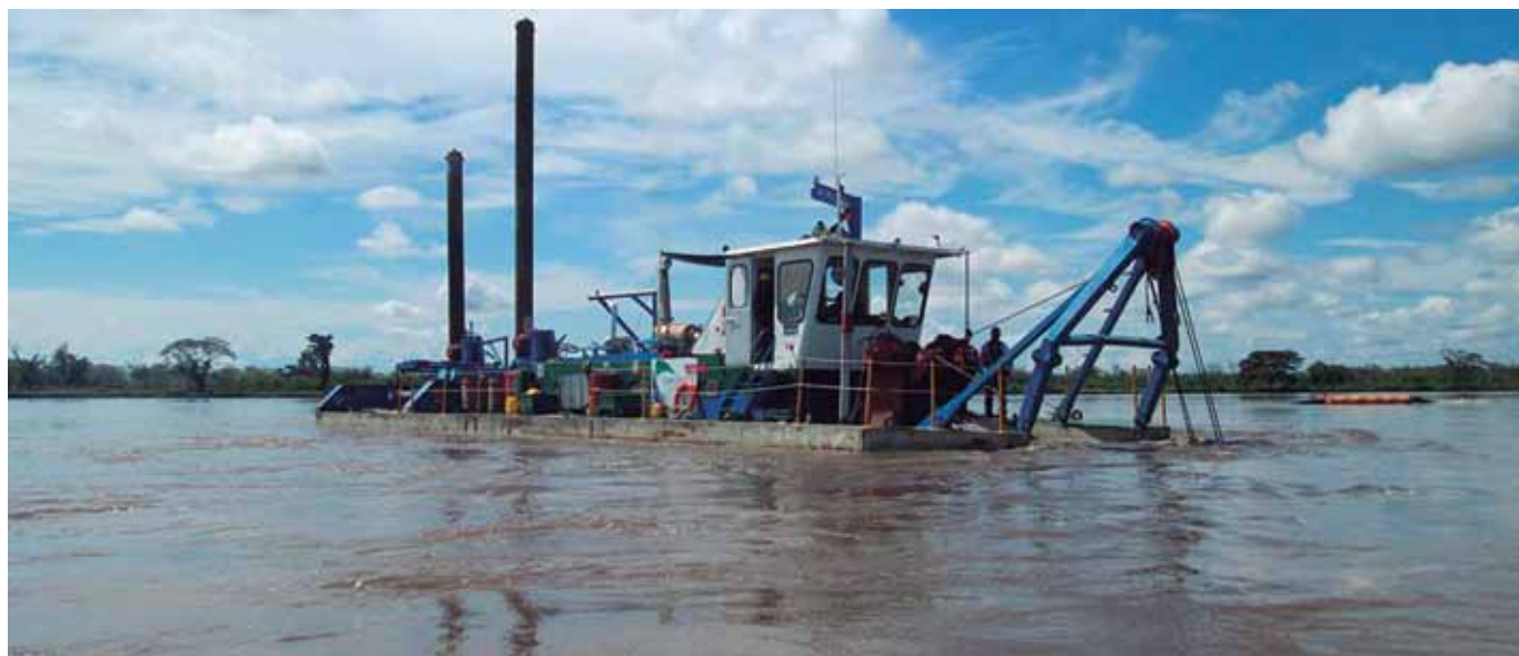
Imagen: Mantenimiento del canal navegable mediante dragado hidráulico en el río Magdalena en el sector comprendido entre Puerto Salgar/ La Dorada (Cundinamarca/Caldas) – Barrancabermeja (Santander).” Utilizando las dragas de corte Río Magdalena y Don David, draga de succión en marcha Mahury. Tomado de: http://www.dragadoshidraulicos.com/index.php/proyectos/realizados/76-rio-magdalena
