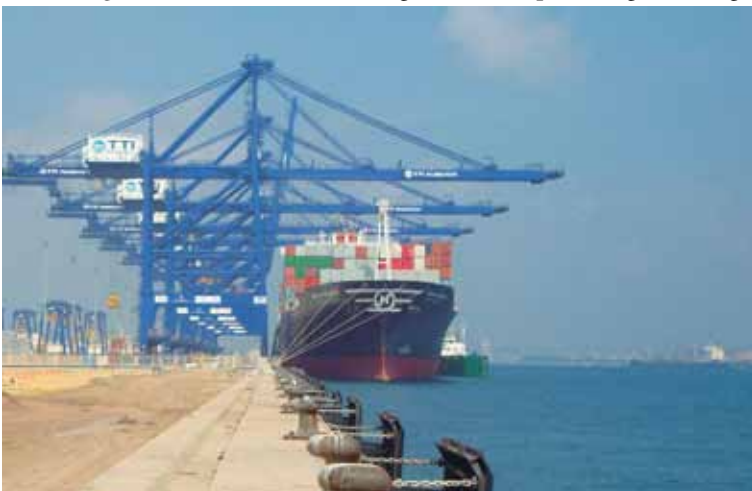
Imagen: Muelle TTIA Puerto Algeciras www.puertoalgeciras.org
