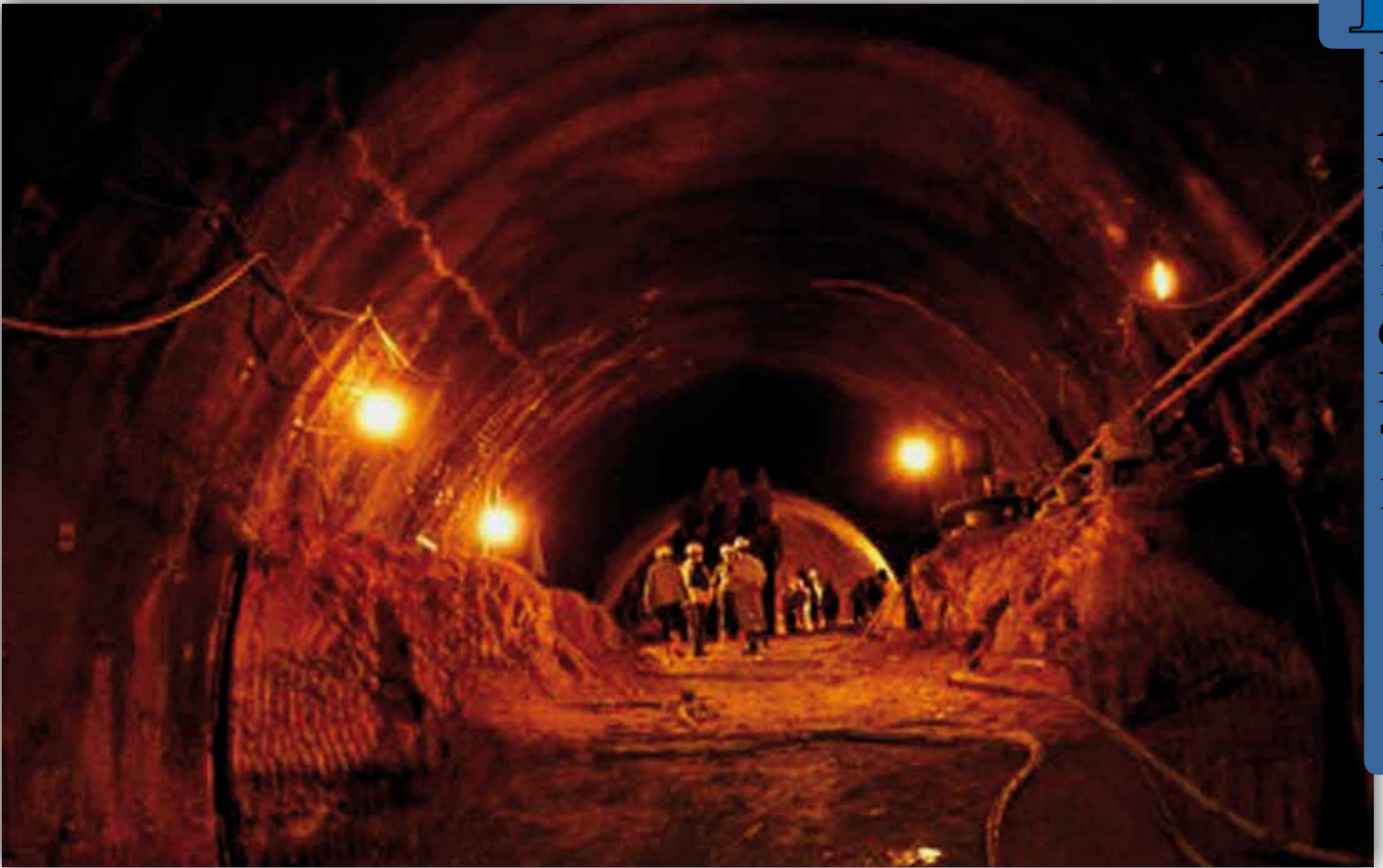
Túnel de la línea. Foto:www.cpampa.com
